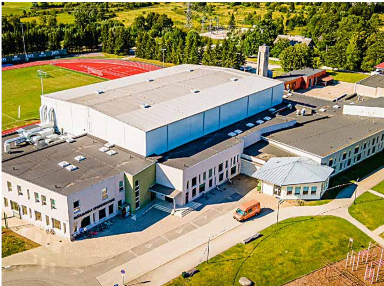
Evakuatsioonikohtadeks on kõik suuremad spordihooned maakonnas. Pildil Märjamaa Spordihoone.
